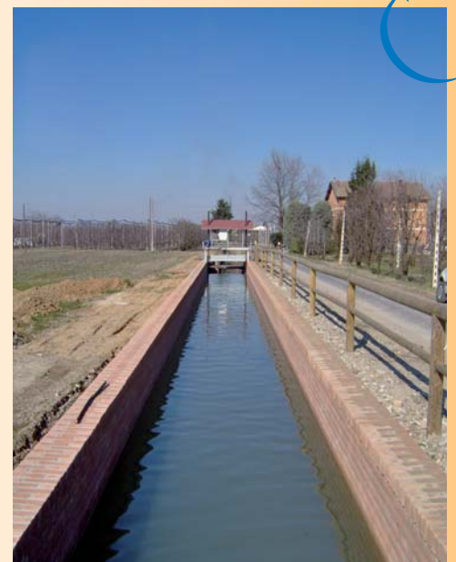
VASCA DELLA STAZIONE DI POMPAGGIO
